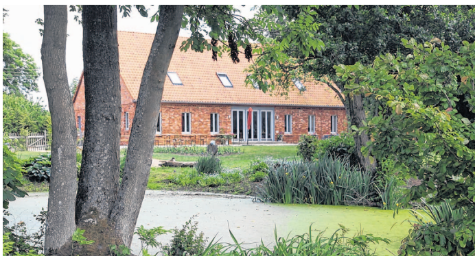
Die Pfarrscheune wurde 2009 wieder aufgebaut.
